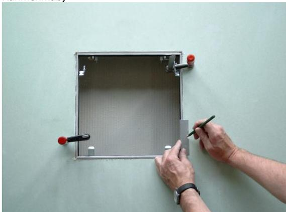
3. Rahmen ausrichten (Winkligkeit prüfen), festspannen und Bohrungen mit Schablone anzeichnen, Bohrabstand <250 mm
