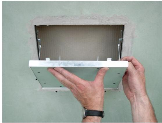
6. Klappen einhängen, sichern und verschließen
