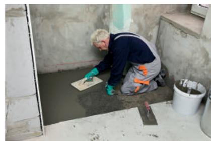
PCI Novoment M1 plus ist ein Schnellestrich-Fertigmörtel und daher eine wirtschaftliche und besonders praktische Lösung für den Einbau von kleineren Flächen und Estrich-Teilflächen, die schnell genutzt werden müssen.
